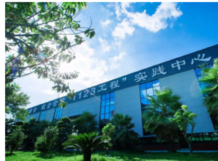
“1123工程”实践中心
