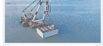
罗南浦：“海上巨无霸”沉箱安装完成
